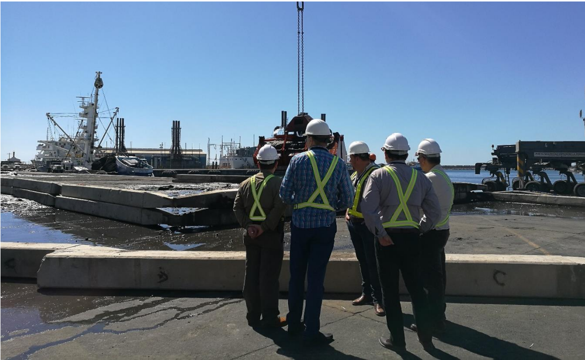
Miembros de la Junta Directiva supervisan los trabajos del dragado
